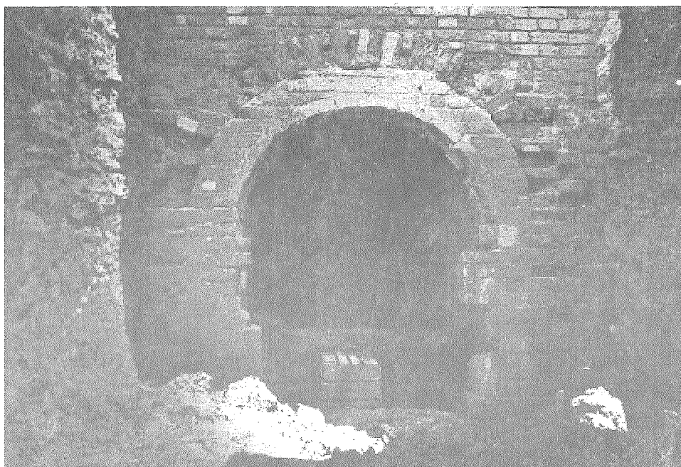
Ryc. 6. Widok wejścia zewnętrznego do piwnicy pod d. refektarzem po jego odsłonięciu; widoczne ślady konstrukcji, zapewne zaniechanej, osłaniającej wejście oraz dostawione w 2 poł. XVII (?) wieku przypory, fot. W. Łukaszewski, VIII 1983
