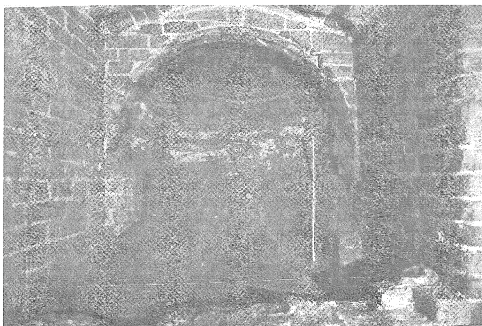
Ryc. 7. Widok wejścia zewnętrznego do piwnicy pod d. refektarzem od wnętrza piwnicy przed odsłonięciem; widoczny układ warstw nasypowych, z których najstarsze pochodzą z XV wieku świadcząc o zaprzestaniu funkcjonowania otworu, fot. W. Łukaszewski, VII 1983
