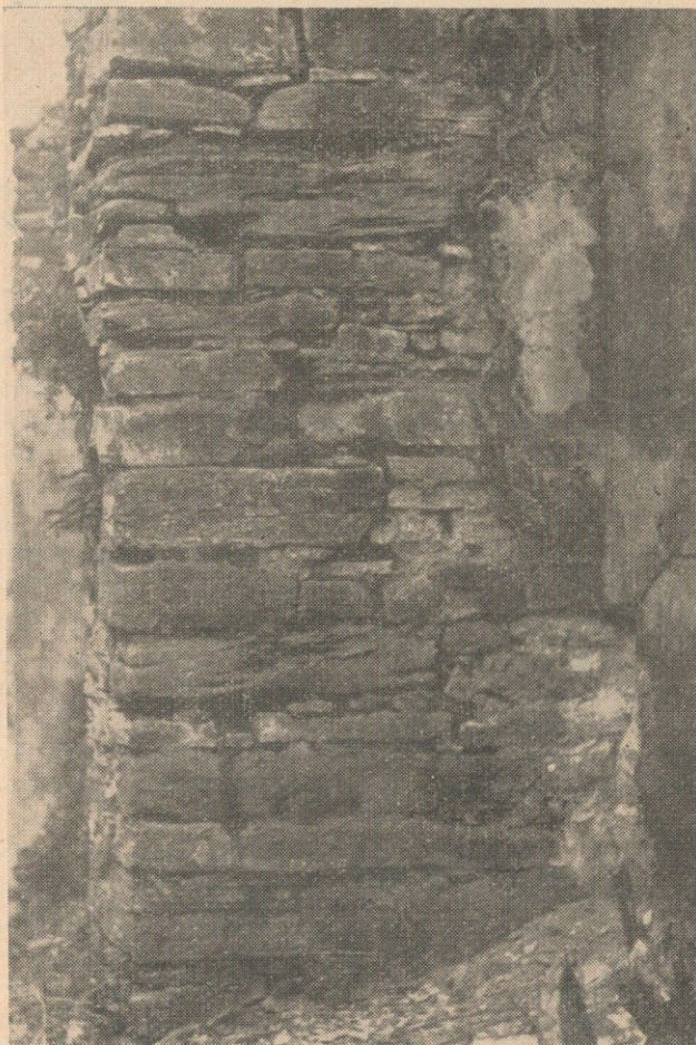
Ryc. 8. Posada Rybotycka pow. Przemyśl. Cerkiew, układ kamieni w licu szkarpy znajdującej się przy północnej ścianie korpusu.
