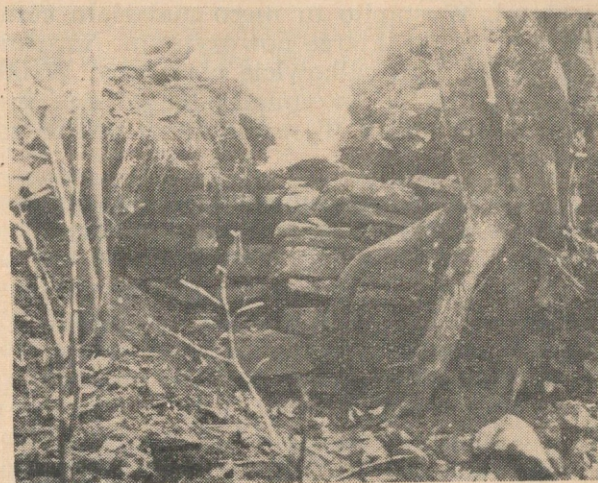
Ryc. 3. Posada Rybotycka pow. Przemyśl. Widok zewnętrznego lica muru w wykopie XVI.
