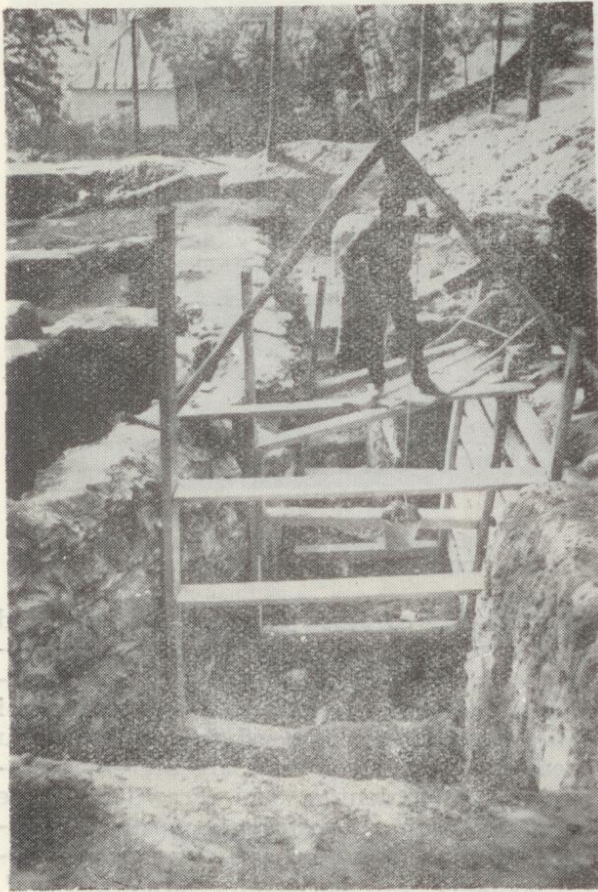
Ryc. 4 Fundament zachodni szyi barbakanu (Fot. A. Hadała)
