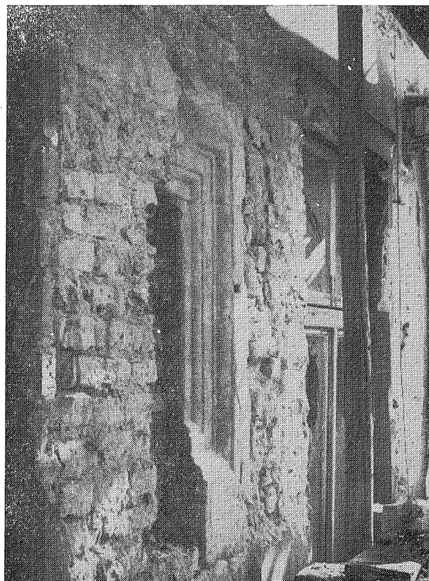
Ryc. 12. PRZEMYŚL m. pow. Rynek 11. Fragment odkrytego obramienia okiennego.
