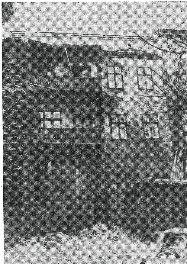
Ryc. 7. PRZEMYŚL m. pow. Rynek 11. Wschodnia elewacja kamienicy. Stan w lutym 1967 roku.
