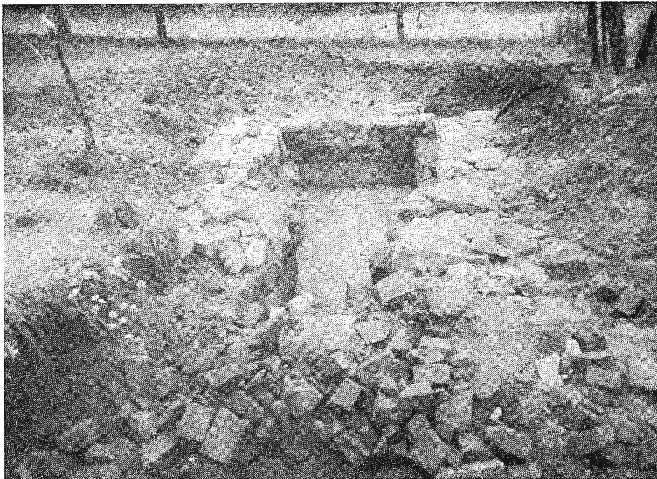
Ryc. 2. Głuchów, pow. Łańcut, stan. 1. Widok pieca po eksploracji.
