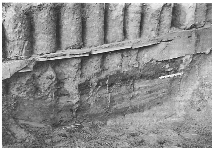
Ryc. 5. Krosno – rejon Sądu Okręgowego w Krośnie. Zarys fosi przed murem obronnym w profilu zachodnim wykopu fundamentowego pod nowe skrzydło gmachu Sądu
