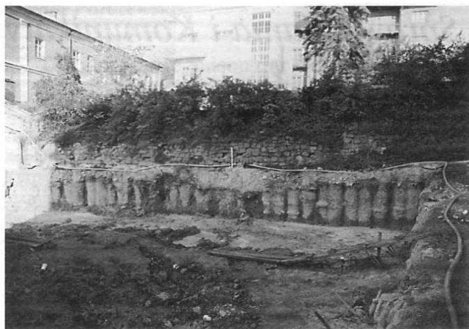
Ryc. 2. Krosno – rejon Sądu Okręgowego. Widok muru obronnego od strony ul. Czajkowskiego
