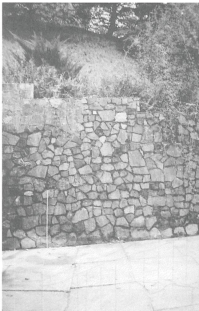
Ryc. 5. Łañcut, stan. 1. Miejsce występowania pali drewnianych u podnóża wzgórza Łysa Góra, na parceli Pana Tadeusza Szczepanika (kamiennoy mur wykonał właściciel). Fot. A. Gruszczyńska
