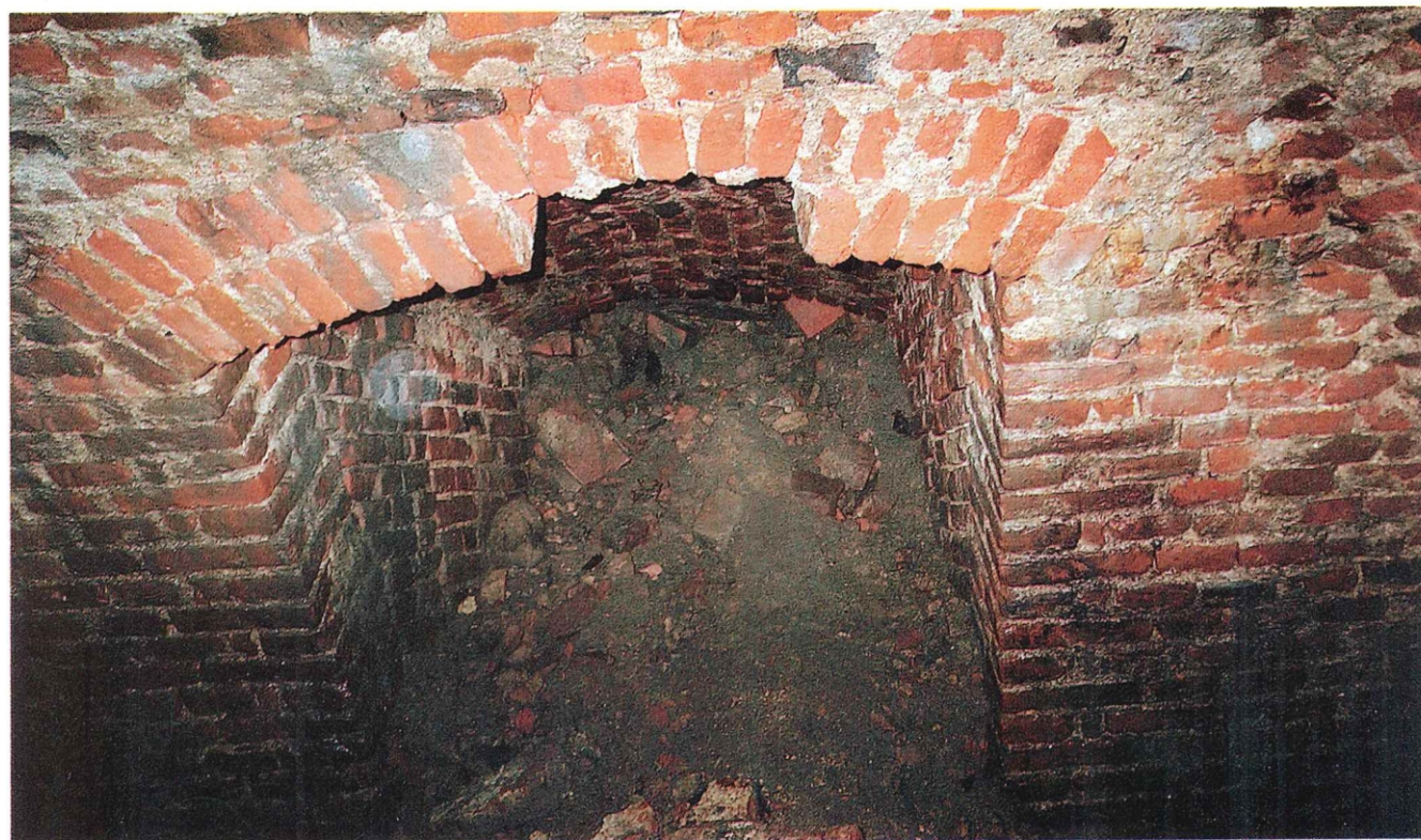
Fot. 2. Łańcut. Zespół parkowo-zamkowy (stan. 6). Teren parku wewnętrznego. Wykop 1. Wnętrze tuneli (podziemnych chodników). Dokumentacja Działu Parku Muzeum Zamku w Łańcucie
