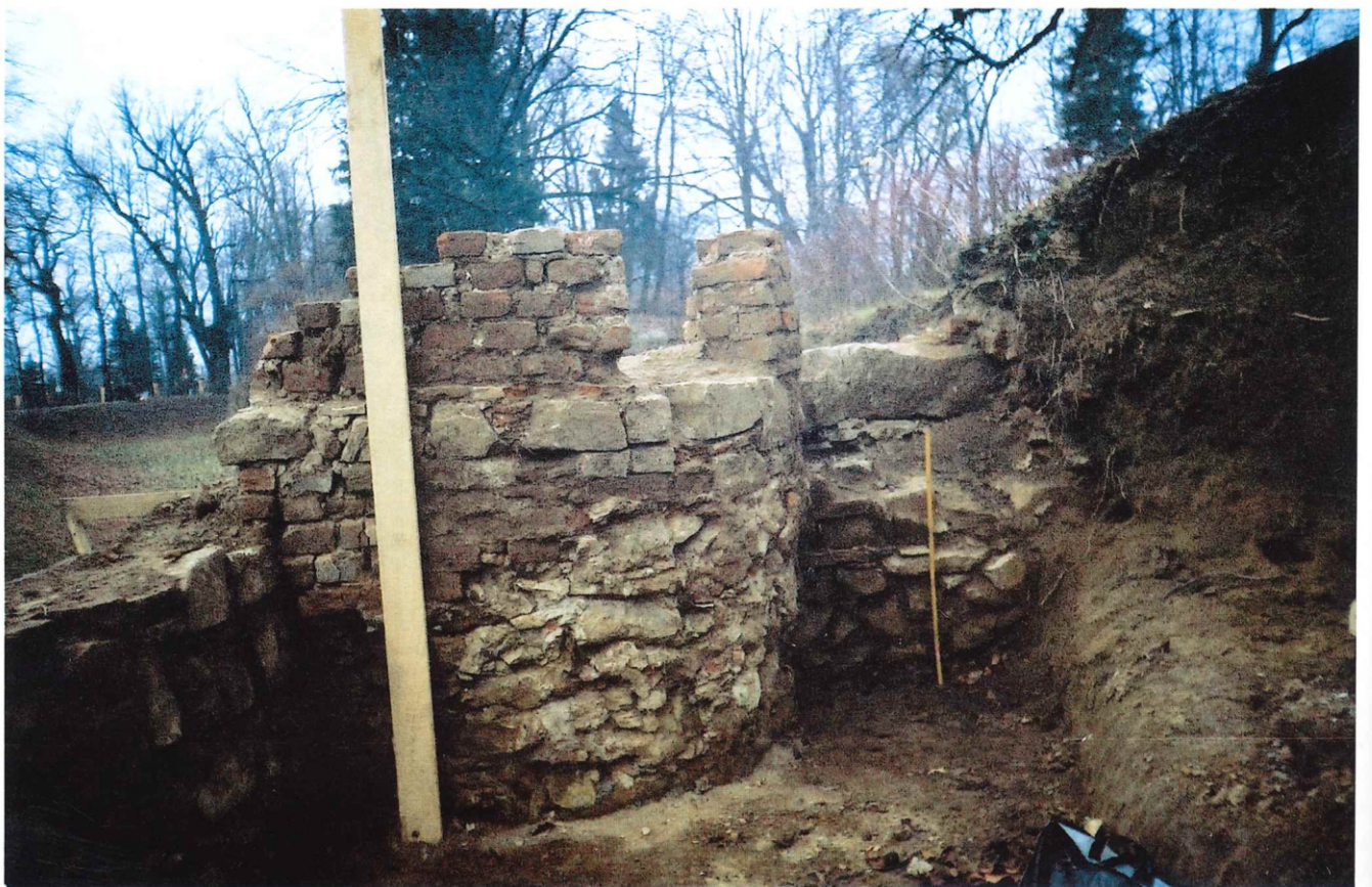
Fot. 4. Łańcut. Zespół parkowo-zamkowy (stan. 6). Bastion północno-zachodni. Widok na kawiernę z odsłoniętym murem obudowy fosy po stronie wewnętrznej, ściana północna i wschodnia wykopu. Fot. A. Gruszczyńska
