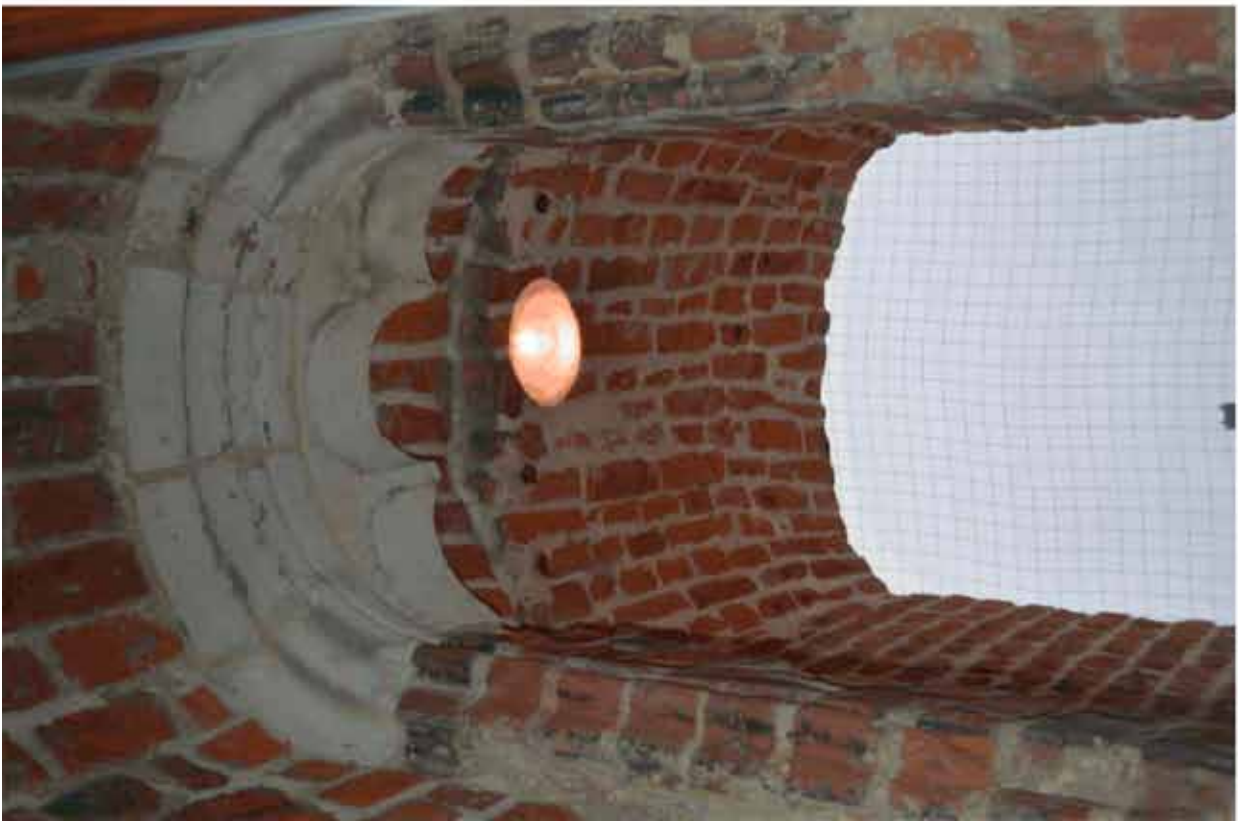
Ryc. 8. Jeden z dwóch otworów okiennych z maswerkiem z trzeciej kondygnacji lubelskiej wieży zamku w Bolkowie. Fot. A. Rozwałka i J. Jeremicz Abb. 8. Eine von zwei Fensteröffnungen mit dem Messwerk des Lubliner Turms im Vergleich zur Fensteröffnung im Turm auf der Burg in Bolków. Fot. A. Rozwałka und J. Jeremicz
