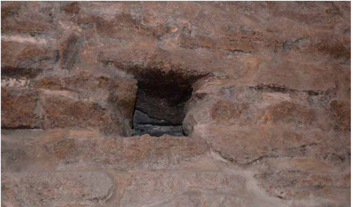
Ryc. 4. Lublin-Wzgórze Zamkowe. Gniazdo po belce stropowej cylindrycznej wieży widoczne od wnętrza pierwszego piętra południowego skrzydła budynku Muzeum Lubelskiego. Fot. A. Rozwałka
