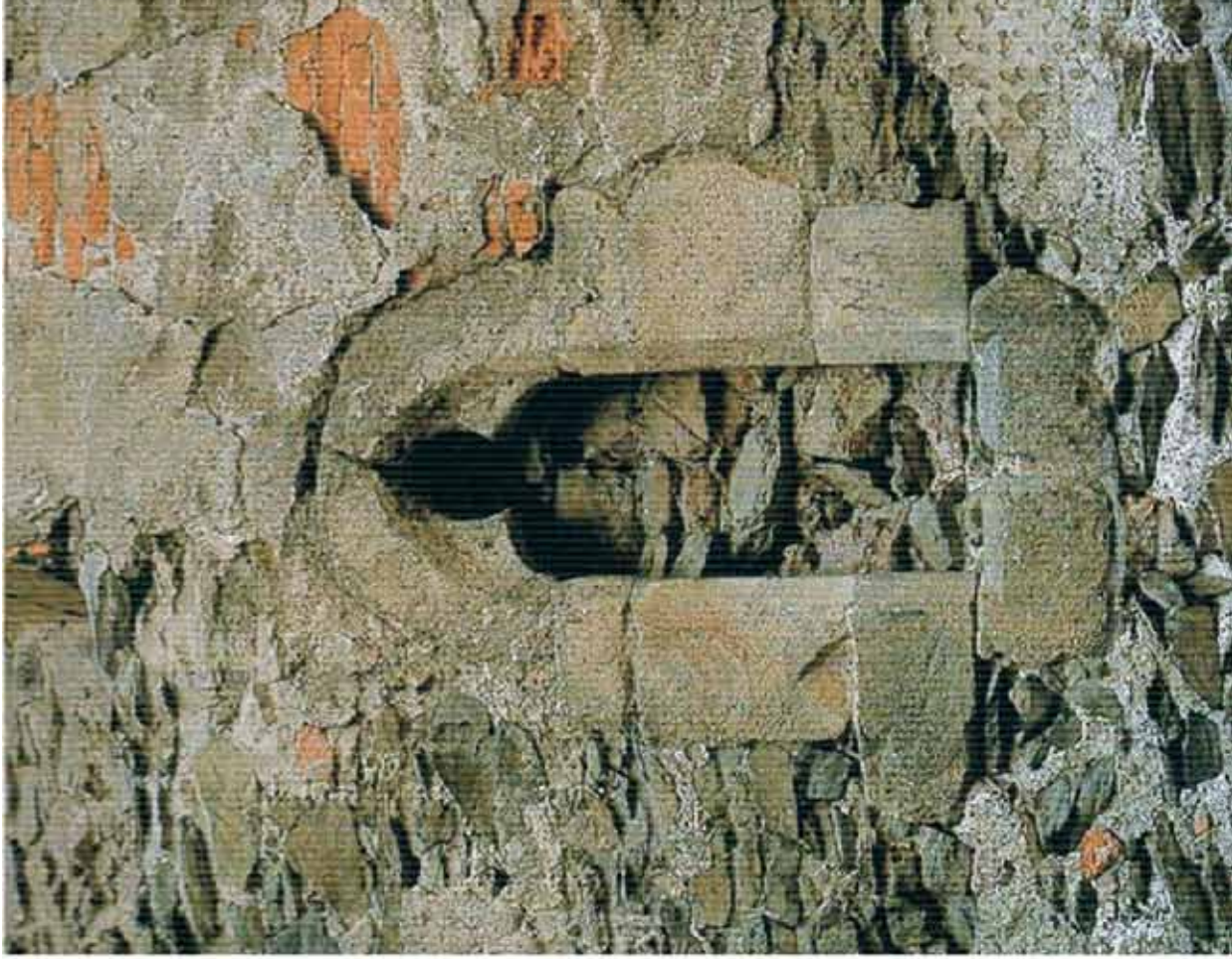
Ryc. 8. Jeden z dwóch otworów okiennych z maswerkiem z trzeciej kondygnacji lubelskiej wieży zamku w Bolkowie. Fot. A. Rozwałka i J. Jeremicz Abb. 8. Eine von zwei Fensteröffnungen mit dem Messwerk des Lubliner Turms im Vergleich zur Fensteröffnung im Turm auf der Burg in Bolków. Fot. A. Rozwałka und J. Jeremicz
