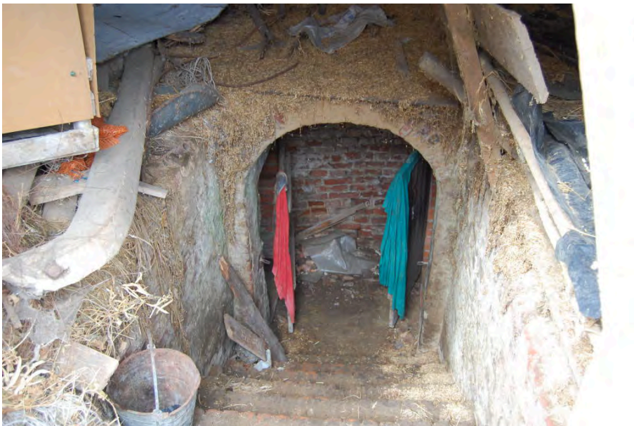
Ryc. 6. Kolonia Gołąb (gm. Michów, pow. lubartowski, woj. lubelskie). Piwnice dawnego dworu pod współczesnym budynkiem gospodarczym (wg A. Rozwałka 2014)
